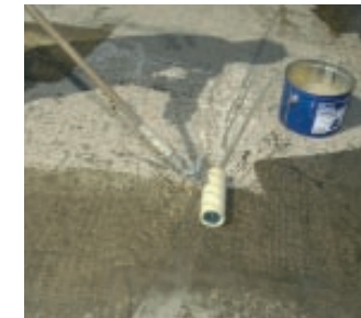
1. Untergrundvorbereitung nach Grundierungsempfehlung
