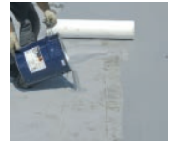
2. KEMPEROL® wird auf den Untergrund aufgebracht
