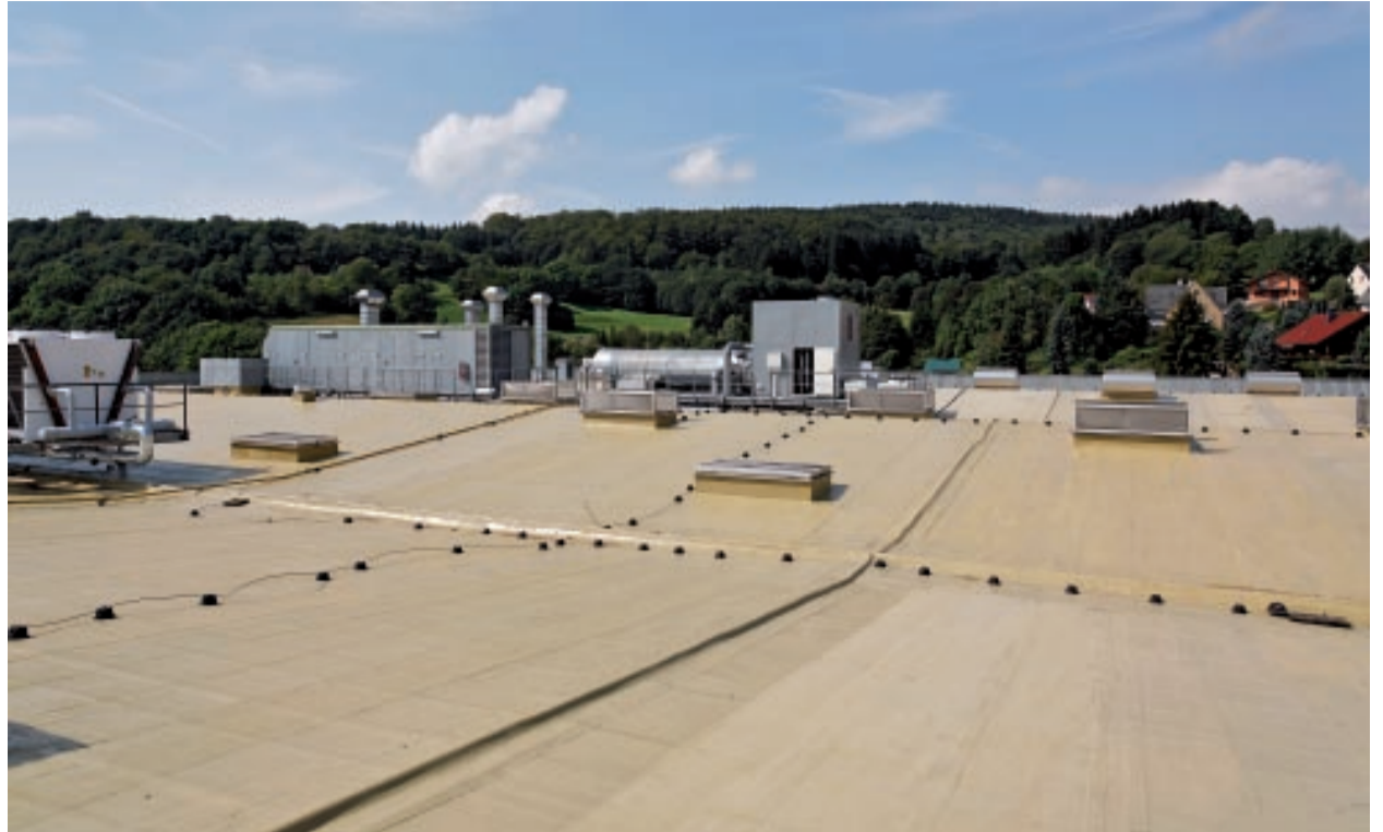
Auf diesem Produktionsgebäude in Brotterode wurden fast 10.000 qm Dachfläche mit KEMPEROL® 2K-PUR abgedichtet.
