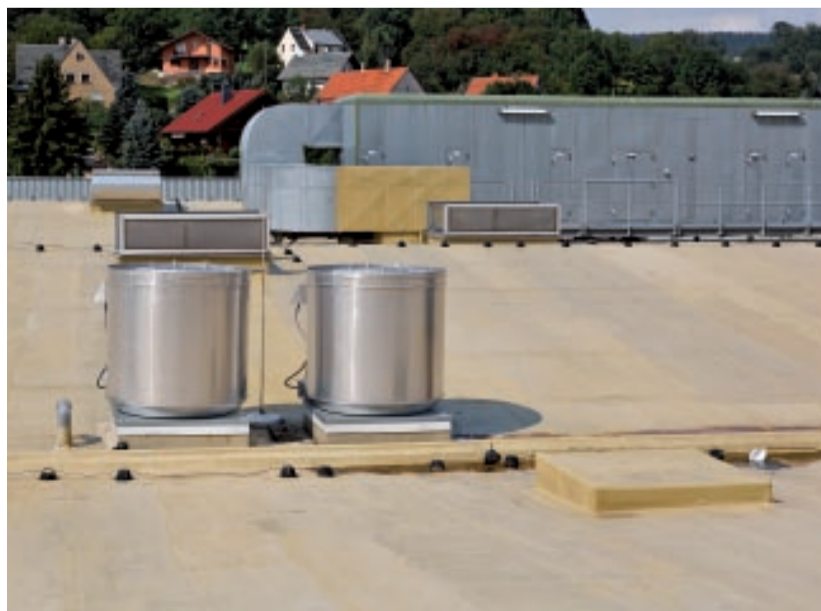
Die Dachfläche ist mit einer Vielzahl von Aufbauten bestückt.
