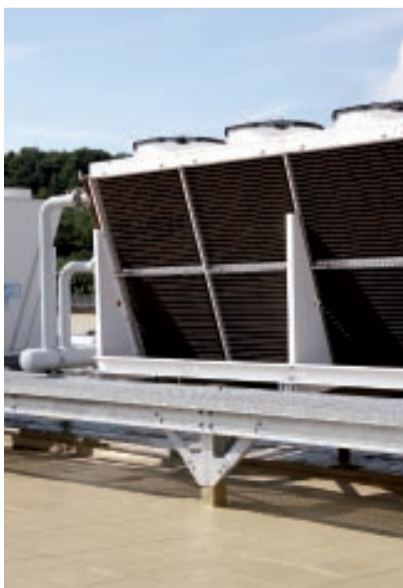
Die Lüftungselemente wurden naht- und fugenlos in die Flächenabdichtung integriert.
